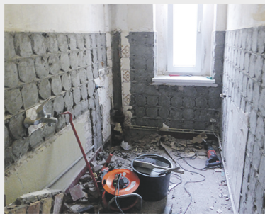
Bad vor und nach der Sanierung. FOTOS: STORKOWER WBG
